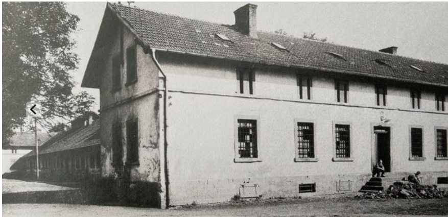
Schlafhaus II der Grube Itzenplitz in Heiligenwald, errichtet 1871 (Foto von 1919) Entnommen aus: Delf Slotta: Der saarländische Steinkohlenbergbau. Bilder von Menschen, Gruben und bergmännischen Lebenswelten, Erzählungen von Zeitzeugen – aufgezeichnet von Georg Fox, Dillingen/Saar 2011, S. 268.
